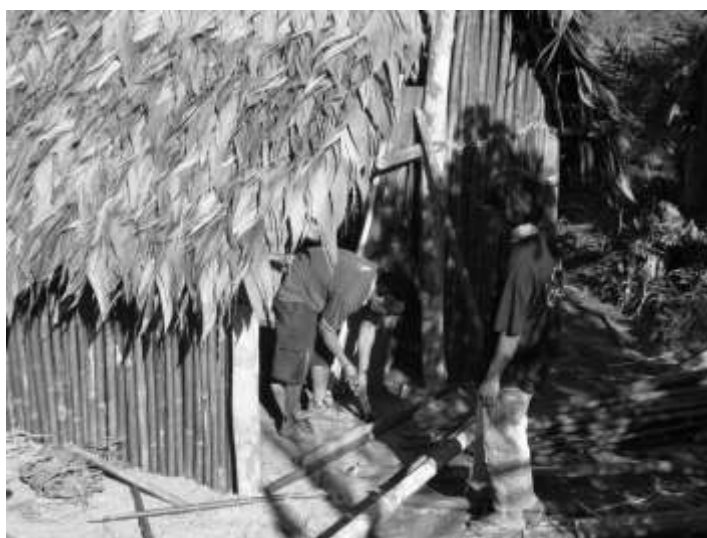
Foto 64 Construção da opy da Pedra Branca
