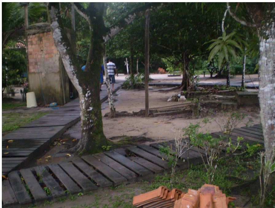
Foto 8: Passarelas do interior do Pré-Núcleo Príncipe Ram. Fonte: Dilma Ribeiro/2010.
